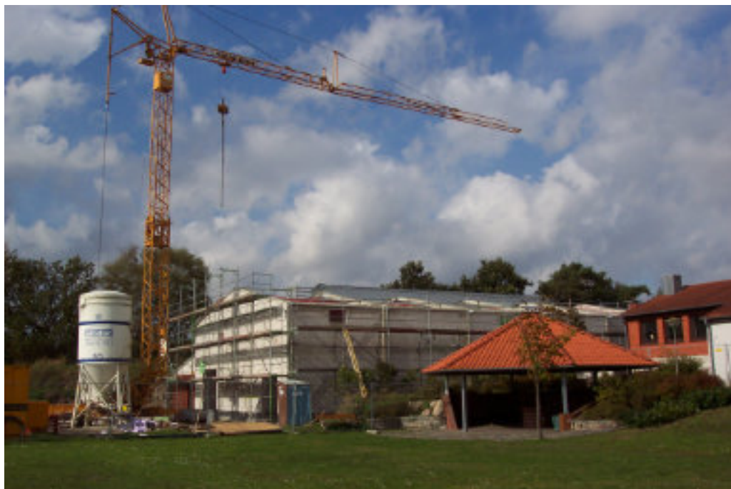
Bauphase der neuen Turnhalle
