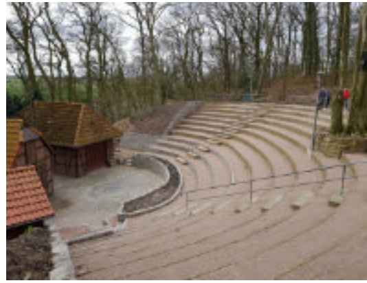
Die neue Ansicht der Freilichtbühne Daverden
