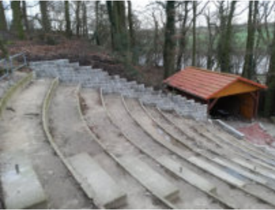
Während der Renovierung...
